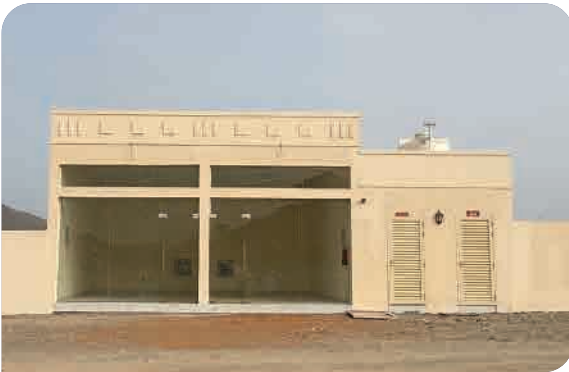
مبنى صناعي مع محلات تجارية الصناعية الجديدة تصميم، بناء
